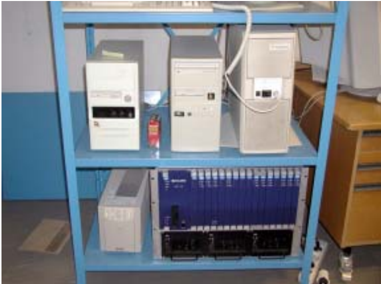
Oulun yliopiston siltarautaa. Alhaalla on uusi Accord MGC-100 videoneuvottelusilta ja UPS-järjestelmä, ylhäällä oikealla yliopiston vanha Videoserver-merkkinen ISDN-videoneuvottelusilta.
