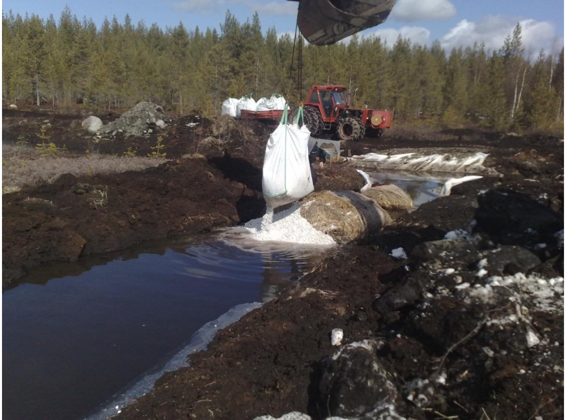
Kuva 6. Kalkkirouheen asettelemista ruokohelpipaalin eteen. (Kuva: Simo Tammela)
