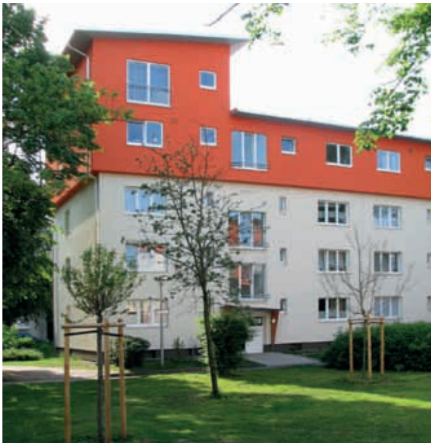
Köln. Korjaus- ja lisärakentamista Ford:n asuntoalueella.
