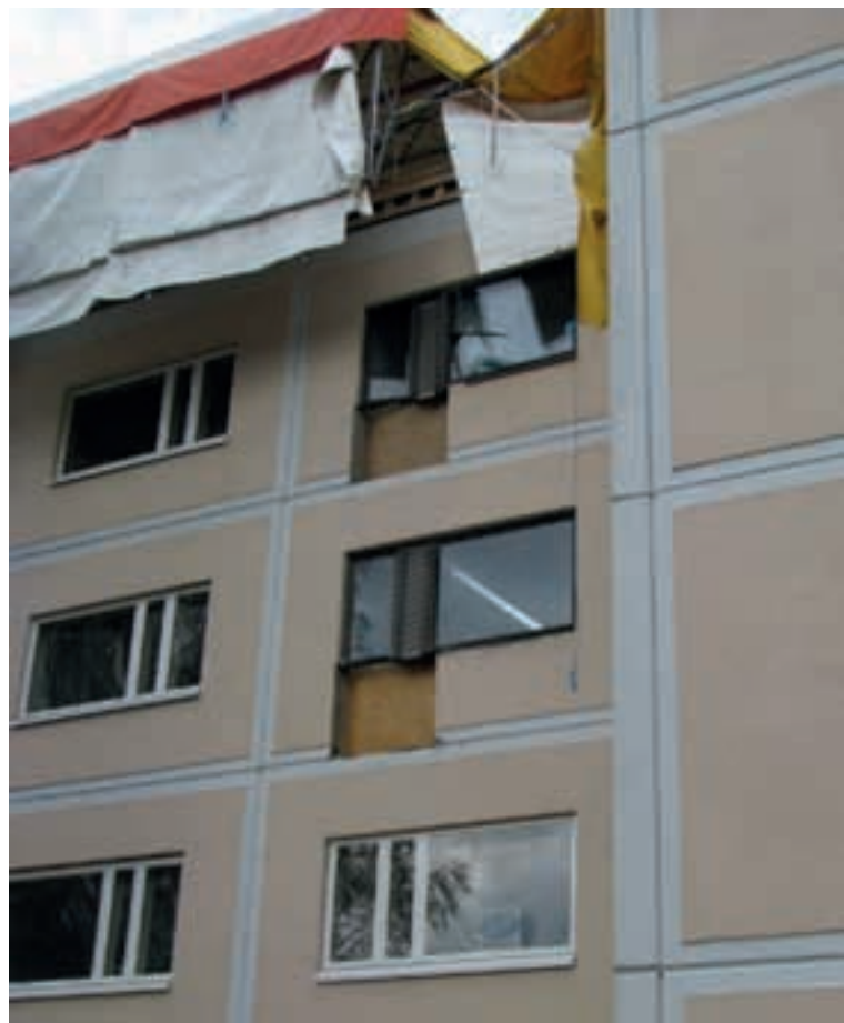
Julkisivukorjauksiin liittyy nykyisin usein paitsi parvekeasennuksia ja ikkunoiden uusimisia myös kattomuodon muutoksia.
