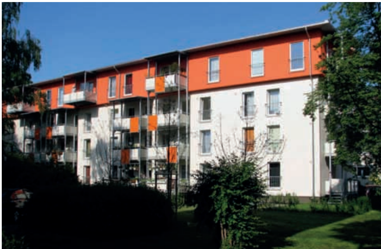
Rakennuksiin on lisätty kerroksia, ulkoseiniin tehokas lämmöneristys ja asuntoihin parvekkeet.
