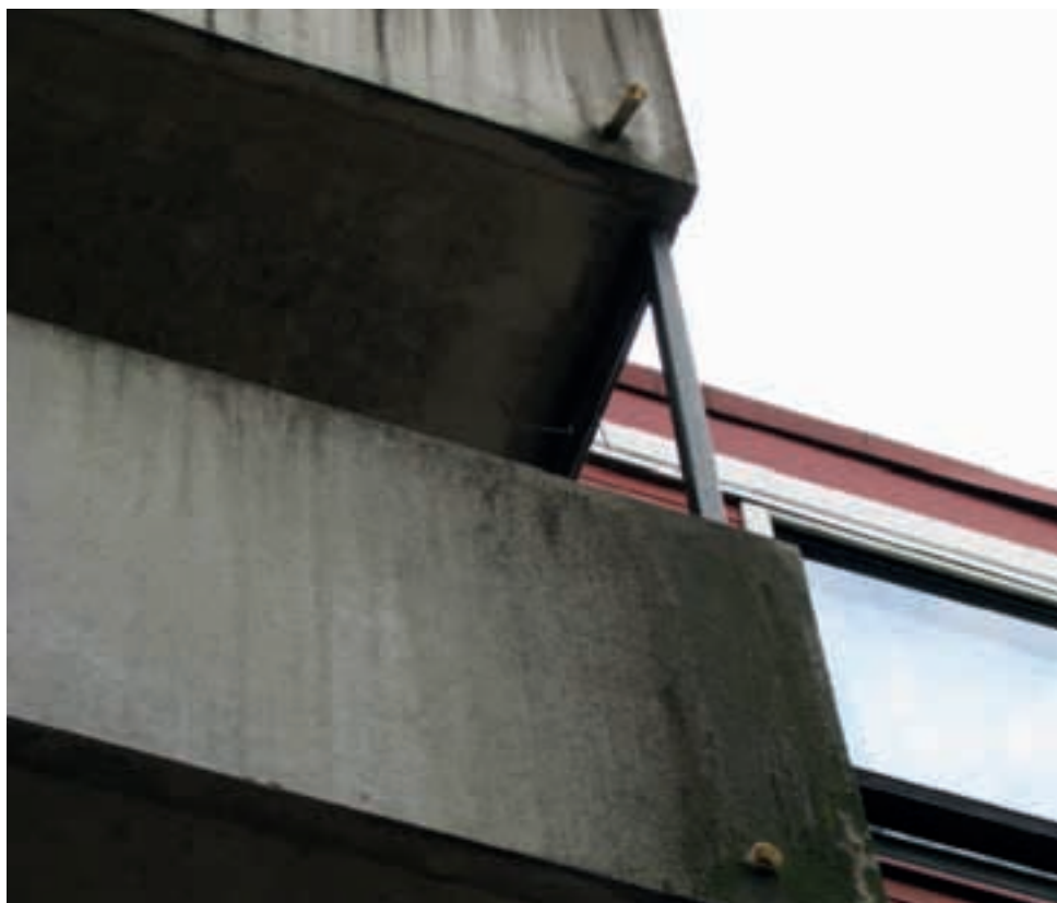
Parvekekorjauksissa ratkaisuja haetaan mm. parvekkeiden huonon kunnon, toimimattoman vedenpoistojärjestelmän sekä niukan mitoituksen aiheuttamiin ongelmiin.
