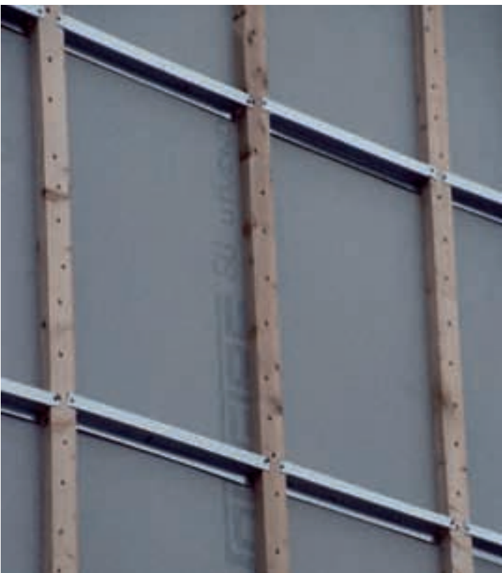
Puujulkisivun tuuletusraon vaakasuuntaisia palokatkoja tulee olla vähintään yksi kerrosta kohden, mieluiten noin metrin välein. Oikeanpuoleisessa kuvassa koeseinä on palanut polttokokeessa 100 minuuttia.
