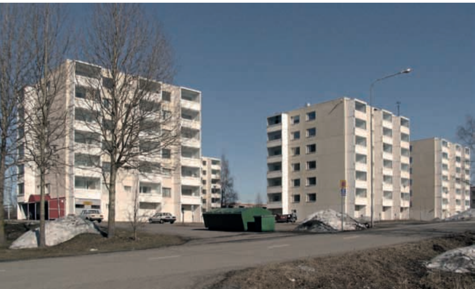
Ratsukadun kerrostaloja vuonna 2009 ennen purkutöitä ja korjauksia.
