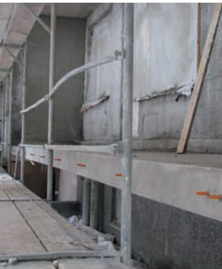
Julkisivujen energiatehokkuuden parantamiseen on yleisesti käytetty ns. lämpörappausa.
