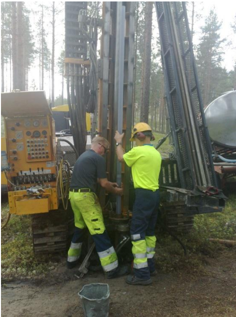
Kuva 14. Pohjavesien putkien asennus. Kuva H.Vikstedt.
