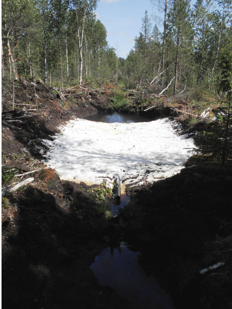
Kuva 45. Kalkkisuodinpato ojalla 2 alhaalta ylävirtaan kuvattuna. Alivirtaama-aikana vettä tulee vain putkesta eikä kentän pinnalle ole merkittävästi saostunut mm. rautaa. Suoto- tai pohjalta kapillaariveden mukana rouheeseen saostunutta ainesta on havaittavissa kuitenkin syvemmissä kerroksissa.
