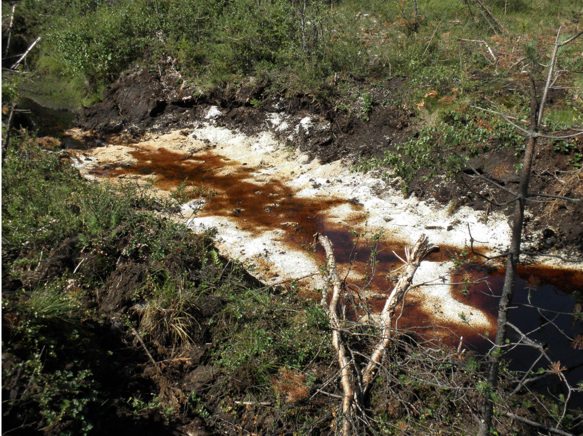
Kuva 46. Syyskuussa 2010 vesi kulki ojalla 1 alivirtaamaputken lisäksi suunnitellusti myös kalkkikentän kautta. Lietekuoppa sijoittuu kuvan oikeaan laitaan ja virtausnopeuden kasvaessa helposti sortuva kentän alapää vasempaan laitaan. Sekä kentän pinnalle että syvemmällä olevaan kalkkirouheeseen on saostunut epäpuhtauksia kuten rautaa.
